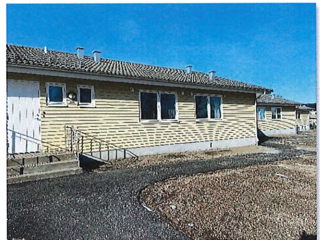
Byte av värmesystem på Tingsmålavägen i Tingsryd
