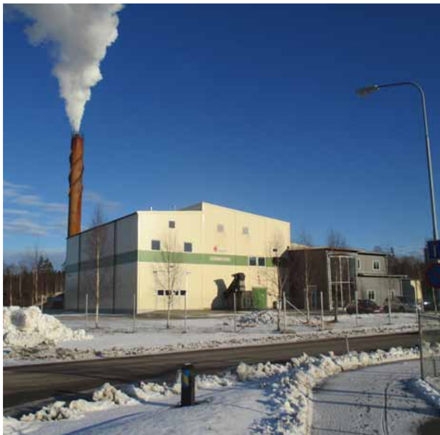
Värmeverket i Tingsryd har kompletterats med ytterligare en biobränslepanna.
