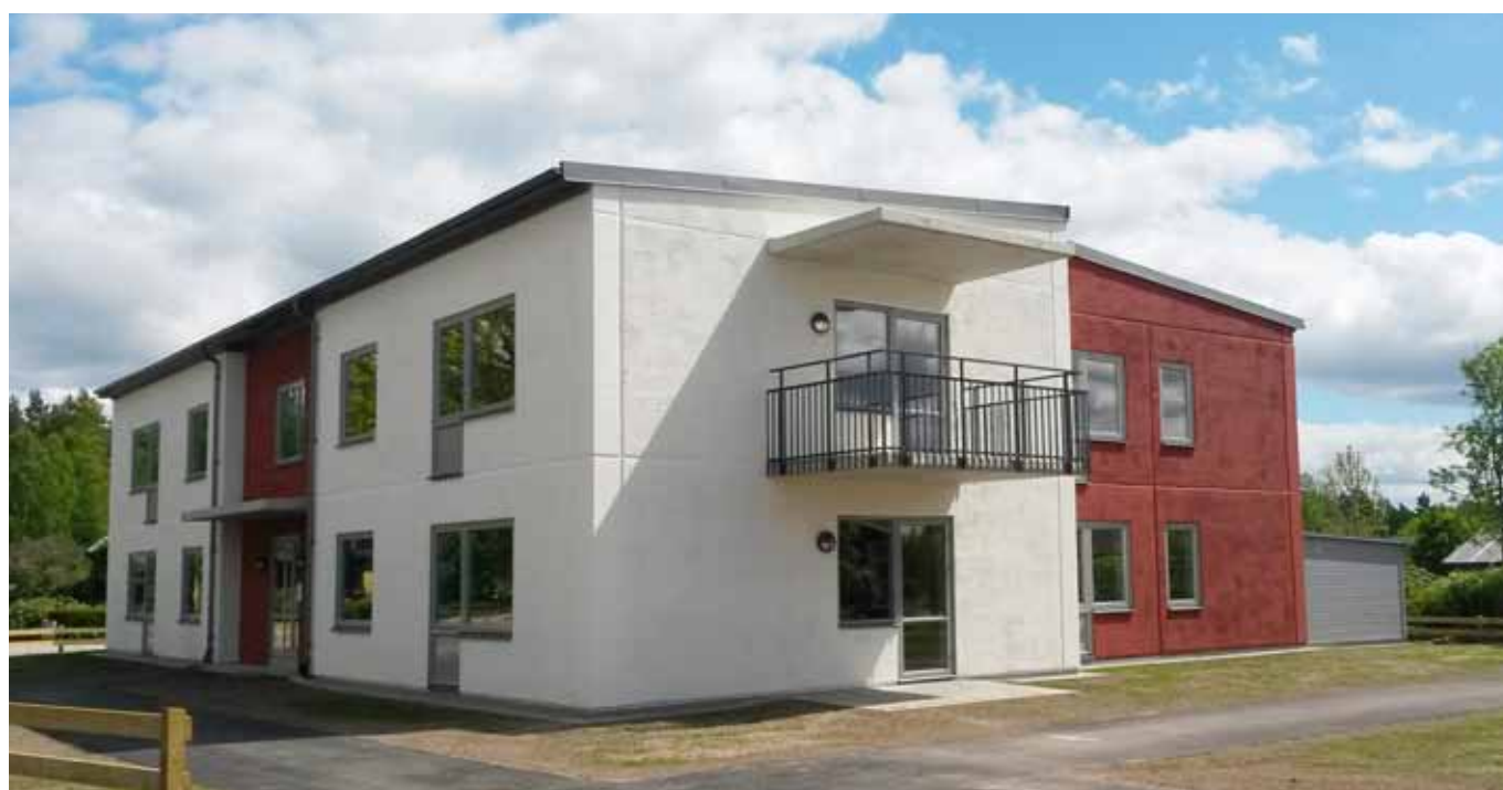
Nybyggnationen på Östrabo 5, Tingsryd.
