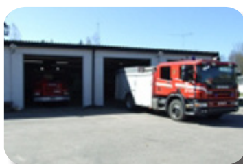
Brandstationen i Ryd har rustats upp.
