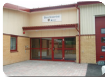
Brandstationen i Tingsryd.
