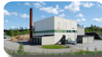
Ytterligare en panna behövs på fjärrvärmeanläggningen i Tingsryd.
