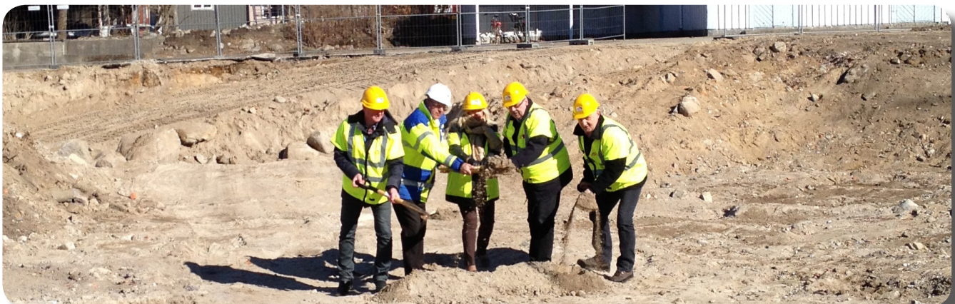
Första spadtaget för vårdcentralen vid kvarteret Örnen.
