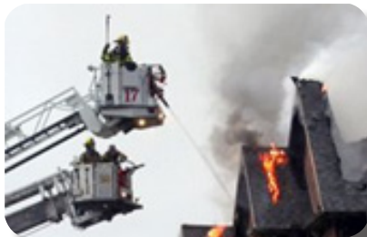
Ett antal räddningsinsatser i byggnader fick genomföras under året.
