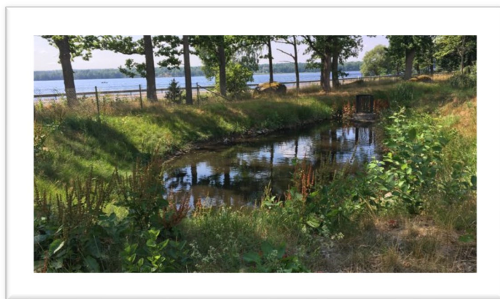
Kommunen har ett antal anlagda dagvattendammar som fördröjer och renar vattnet.
