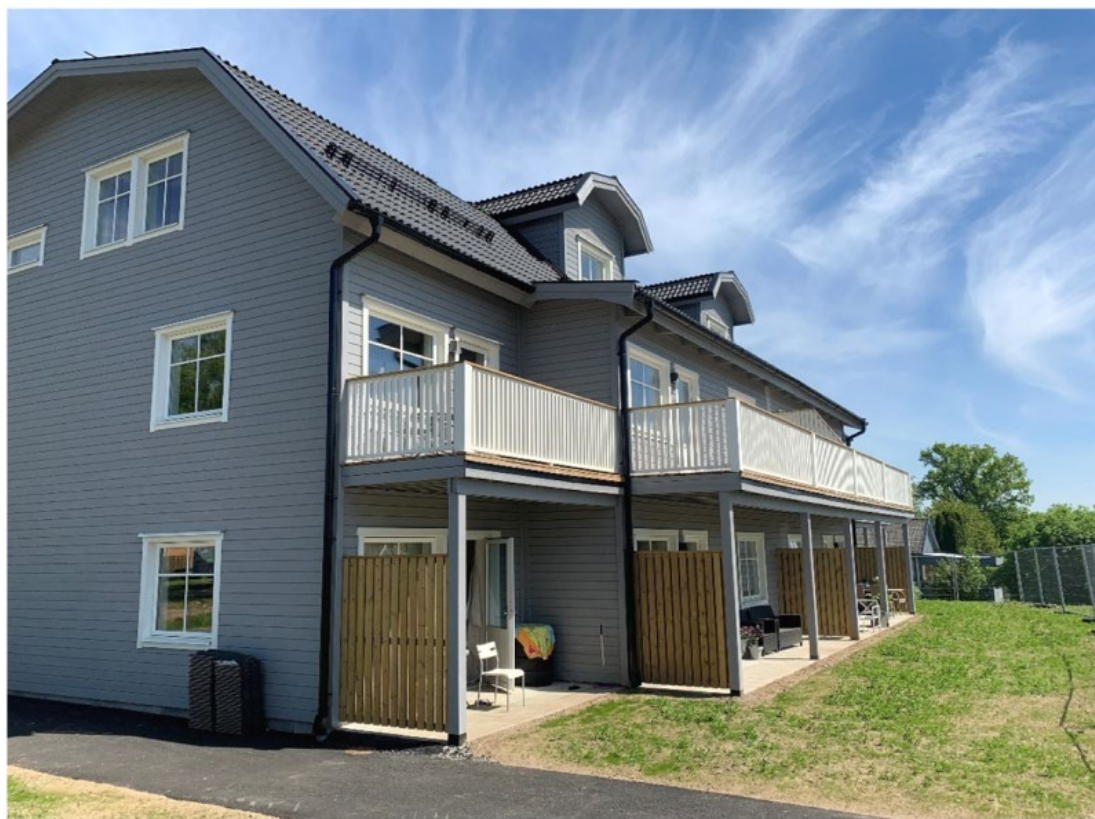
Byggnation av lägenheter i centrala Tingsryd.
