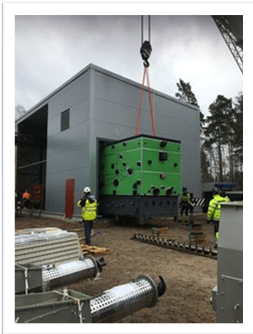
Byggnation fjärrvärmeverk i Linneryd.
